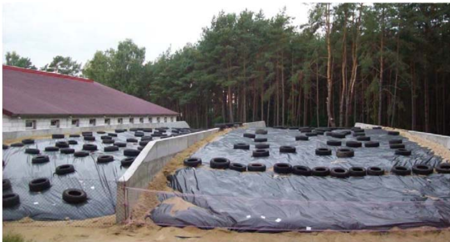
Fot. 1 Przykład prawidłowo wykonanego silosu z sianokiszonką
